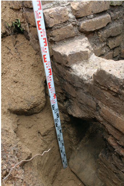
3 pav. Rūmų Š sienos mūro fragmentai su išvietės vieta iš ŠV. A. Zalepūgienės nuotr.
